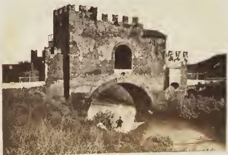
Il Ponte Romano
