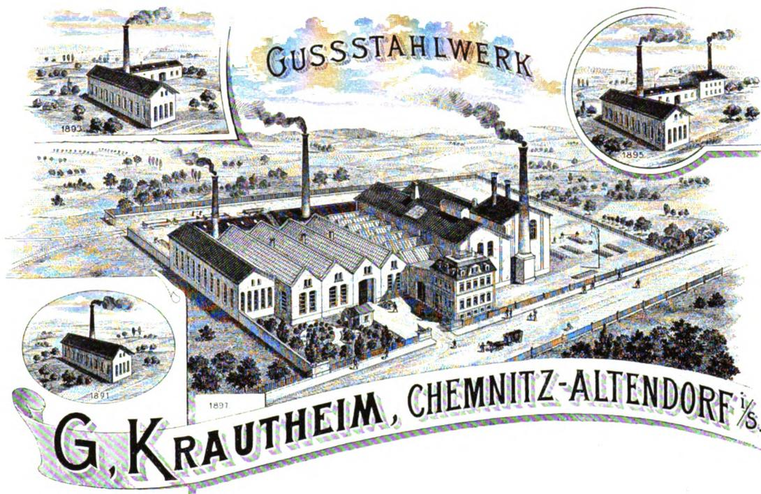
Blowers, eine ausgedehnte hydraulische Hebeanlage, auch elektrische Beleuchtung. Das Werk ist bereits imstande, grosse Stahlgussstücke zu liefern, und es soll Einrichtung zur Herstellung von Stücken bis zu 3000 Kilogramm vorhanden sein.
