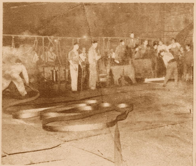
LAMINACION DE HIERROS EN CALIENTE. Se puede observar un fleje que ha pasado por varias máquinas, faltándole tan sólo una, en la cual quedará reducido al espesor deseado, y una palanquilla al rojo que está junto al desbaste, para ser pasada por este cuerpo iniciándose en él su proceso de laminación.
