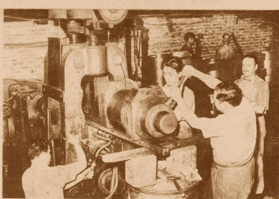
CAMBIO DE CILINDROS EN LAMINACION EN FRIO. Para que los materiales sean perfectos y no existan diferencias en sus espesores, es necesario el cambio de cilindros en forma periódica. Esta fotografía demuestra el instante que se procede a ello.
