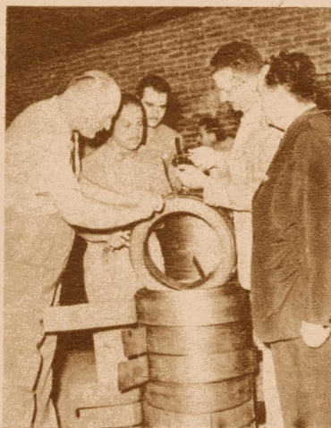
PERSONAL ESPECIALIZADO del establecimiento, controla los anchos y espesores del fleje.
