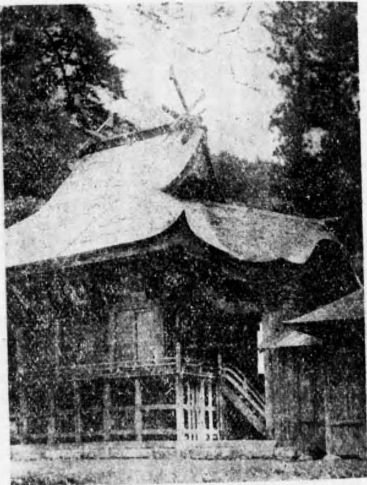
日野上村大字宮内字西馬場筋鎮座 樂々福神社
