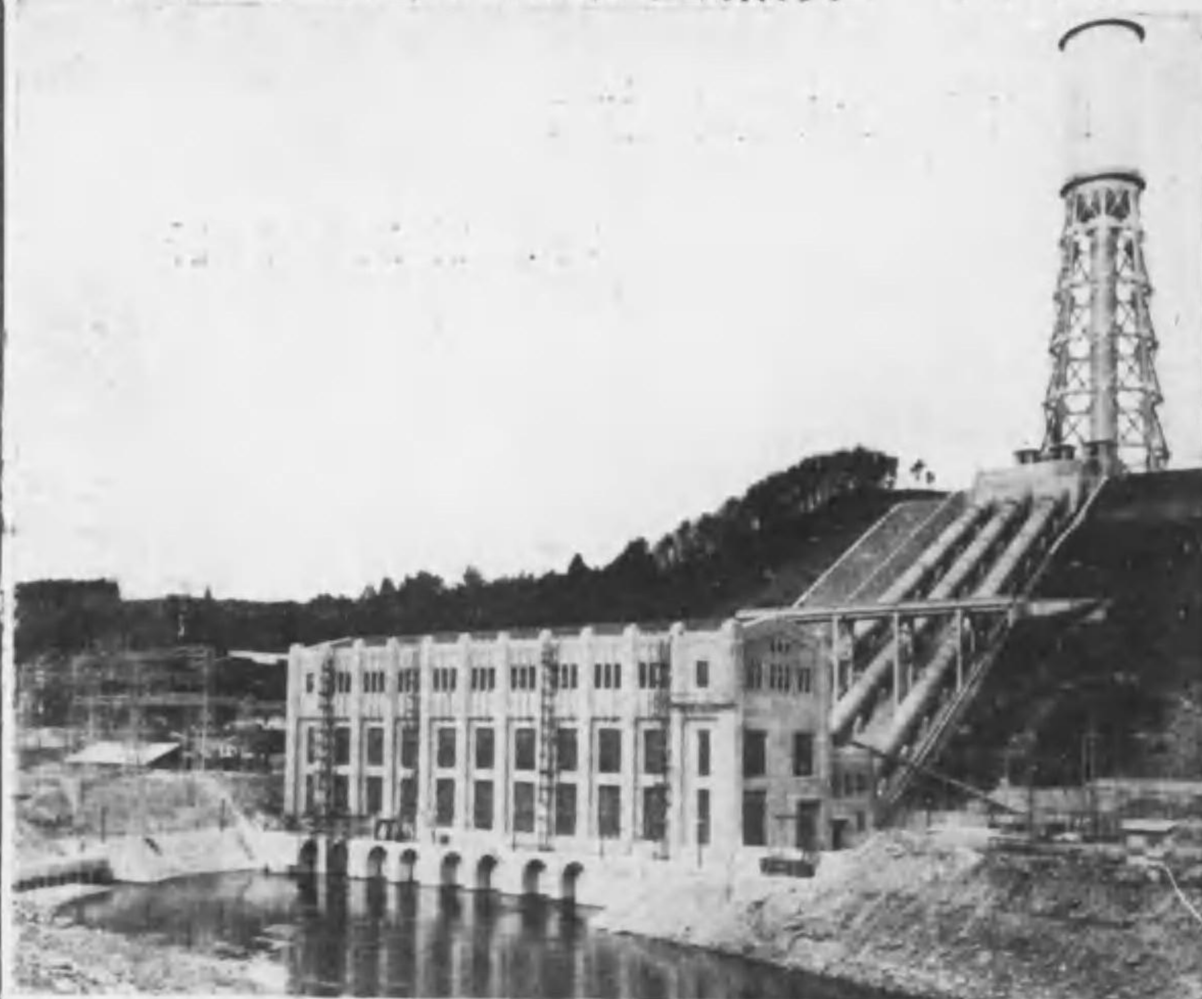
鐵管内徑十五呎、全長四千八百尺、總噸數約五千噸 サージタンク高サ二百八十六呎、タンク内徑四十二呎
