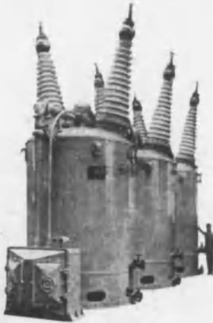
油入遮斷器 遮斷容量 1500000K.V.A.
