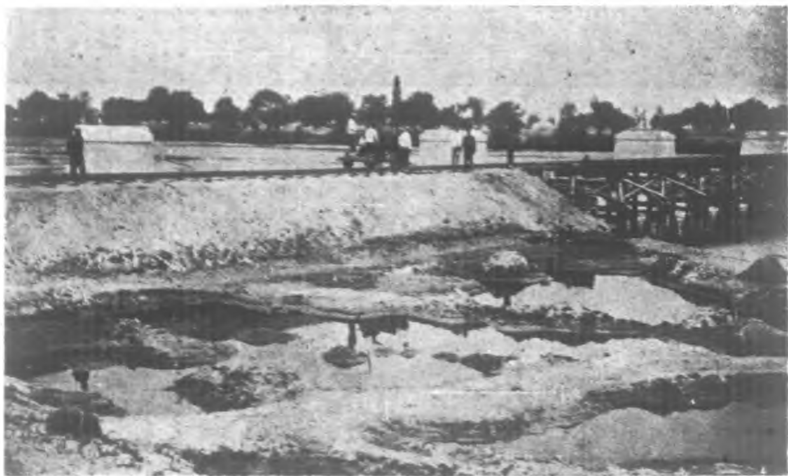
灃河正橋及便道便橋
