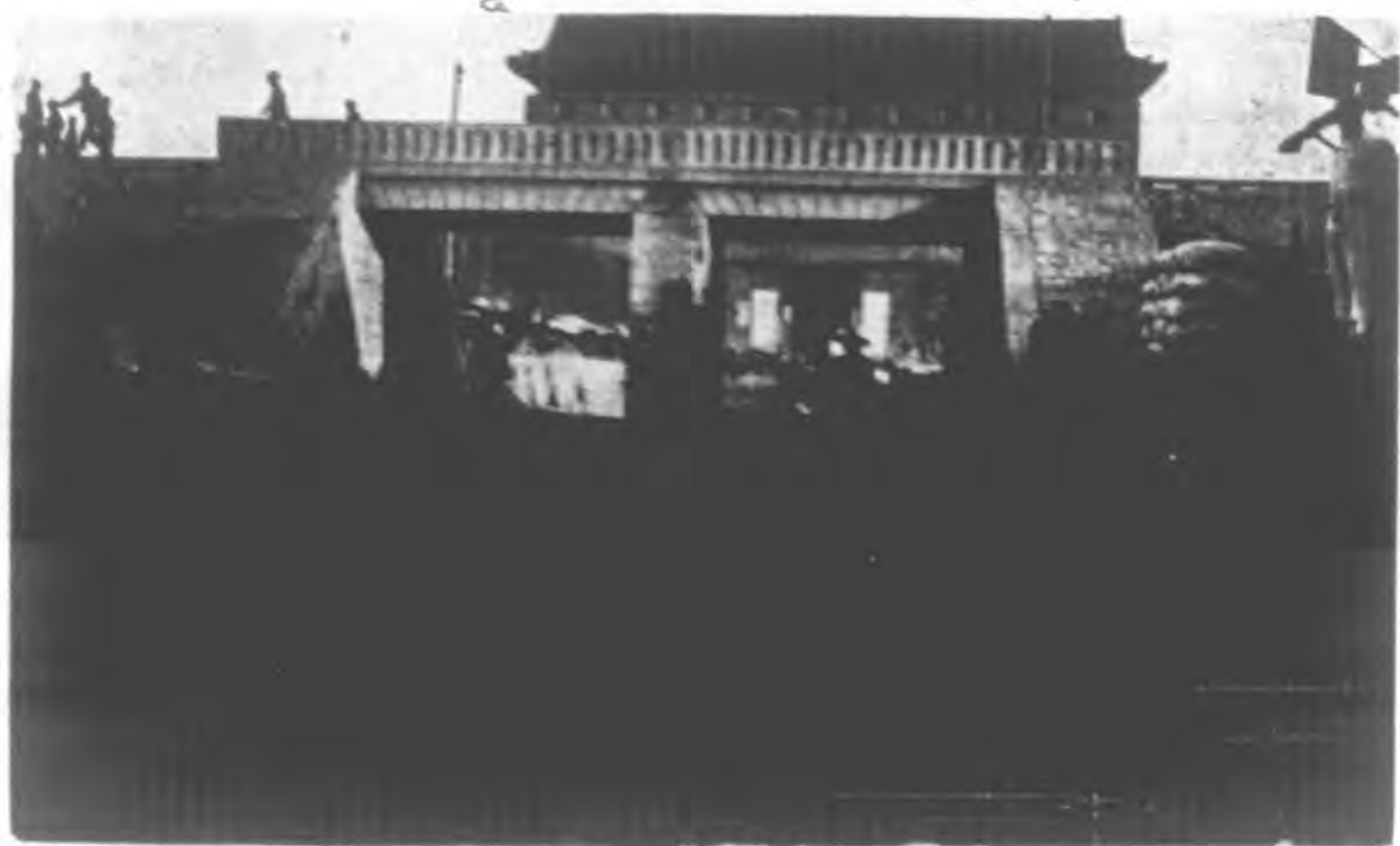
西安北關鐵道道懸橋
