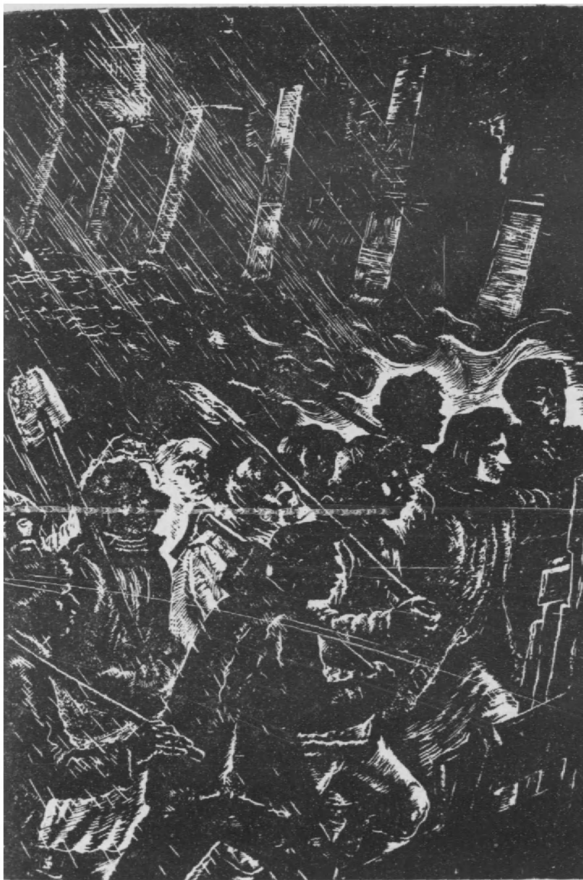
尼泊爾江上的建設
