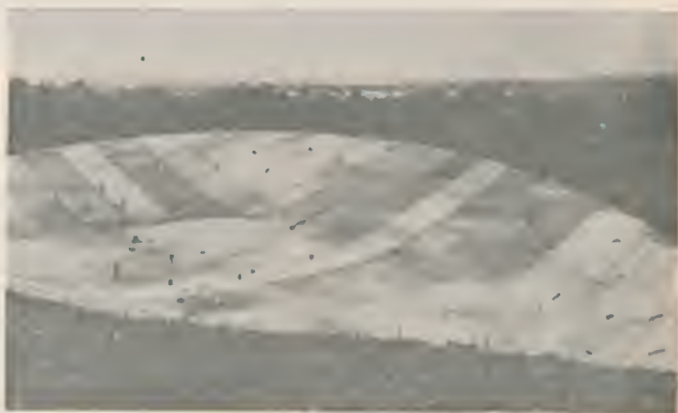
Este reservatório, revestido de plástico, coletará mais de 19 milhões de litros de água para atender às necessidades de uma fazenda de gado, nos Estados Unidos.
