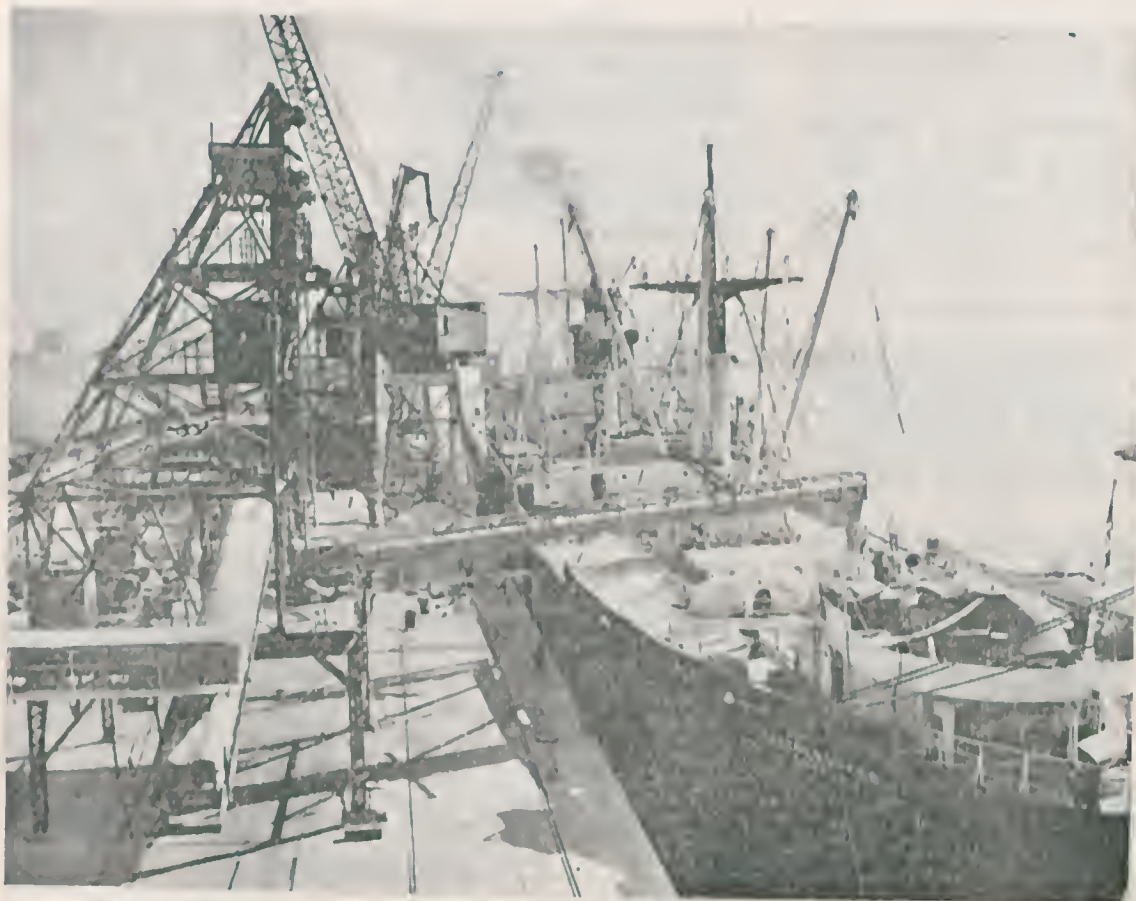
Carregador mecânico de milho com capacidade de 150 t/h. Iguais a este existem mais 5 no pôrto de Santos, dois em cada posição de atracação dos navios recebedores.
