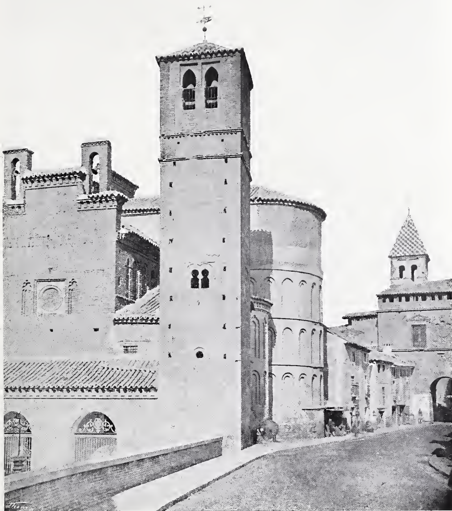
TORRE DE SANT JAUME DEL ARRABAL
