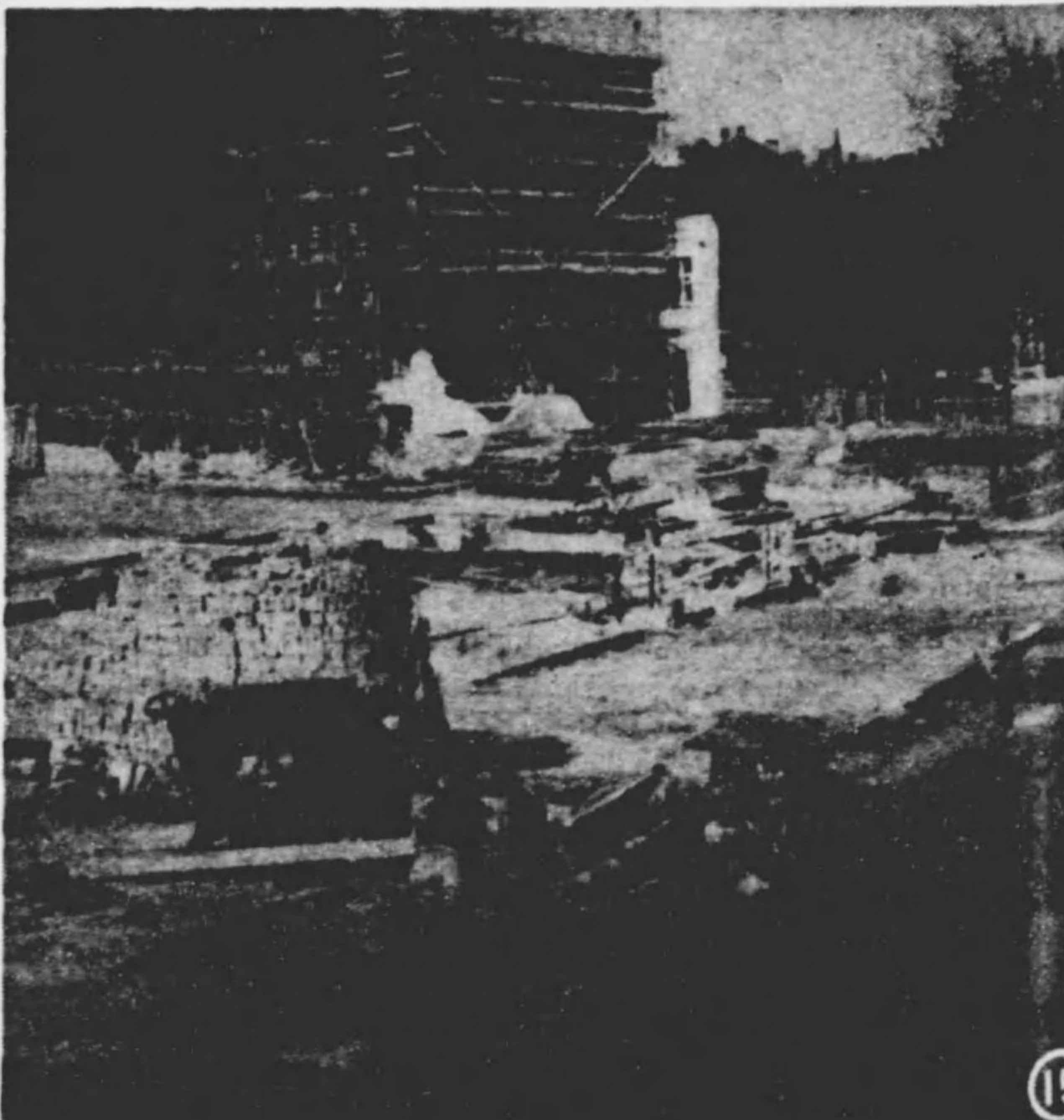
空雷による建物崩壊の跡
