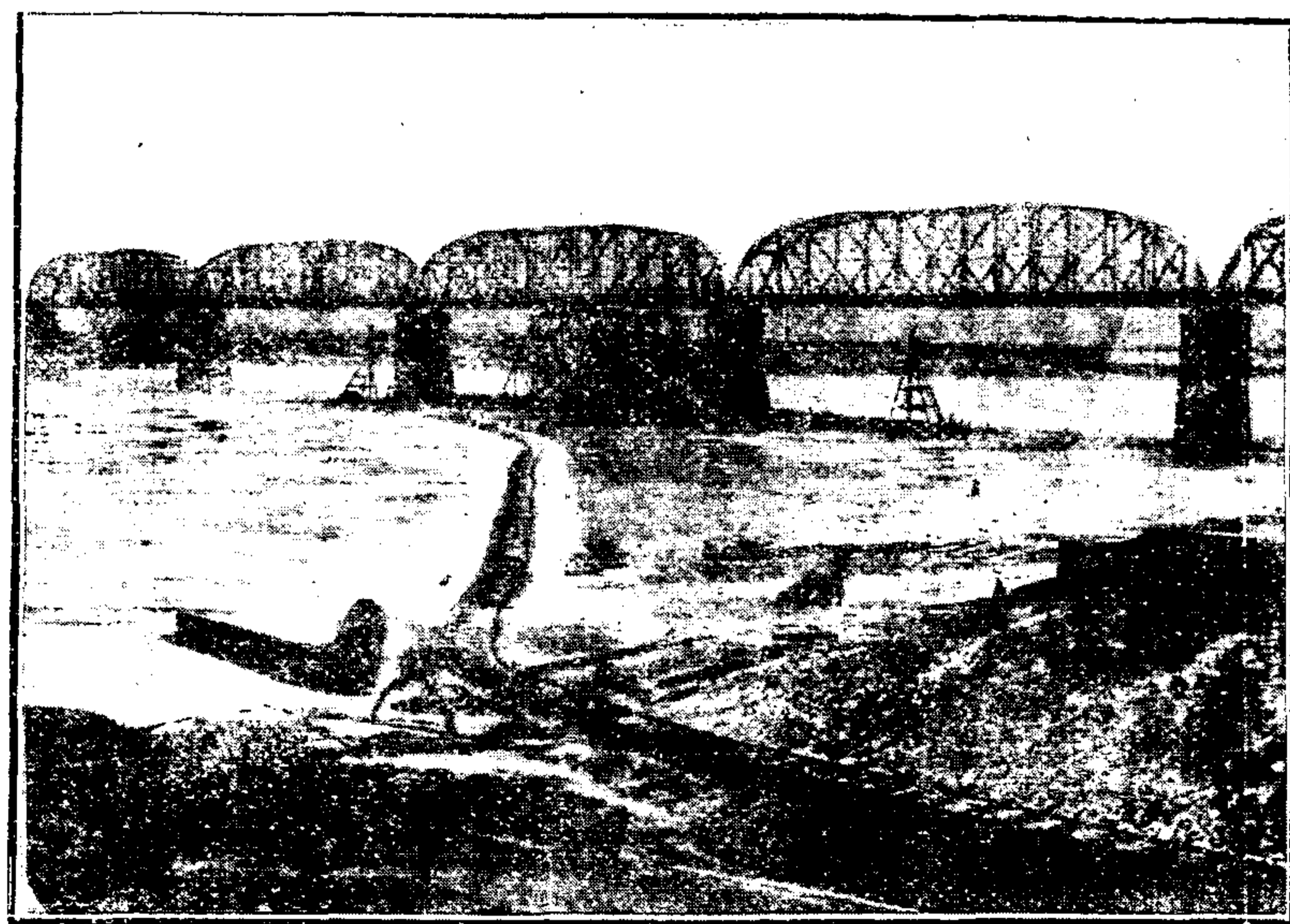
拆卸舊橋梁成塊運往江岸之拍照
