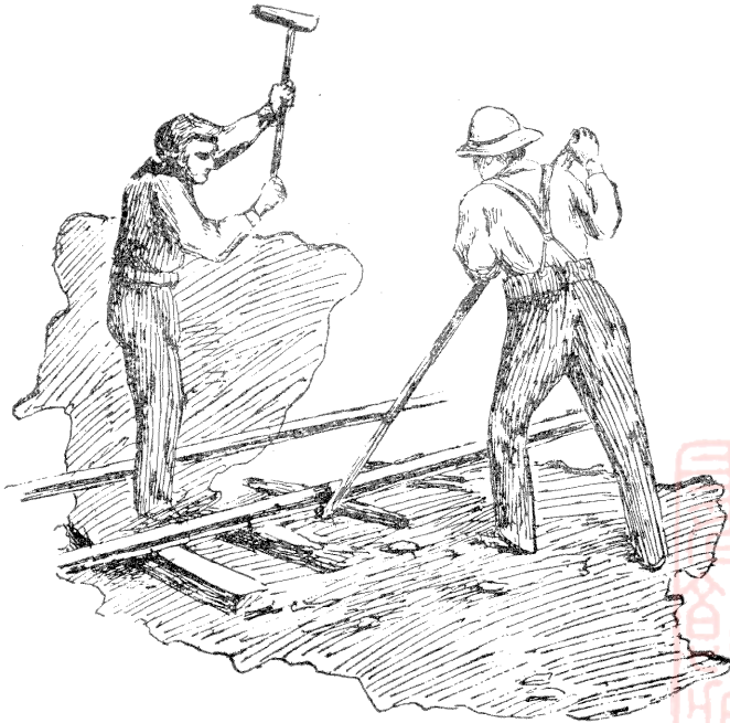
圖軌鋪繫釘 圖五十六第
