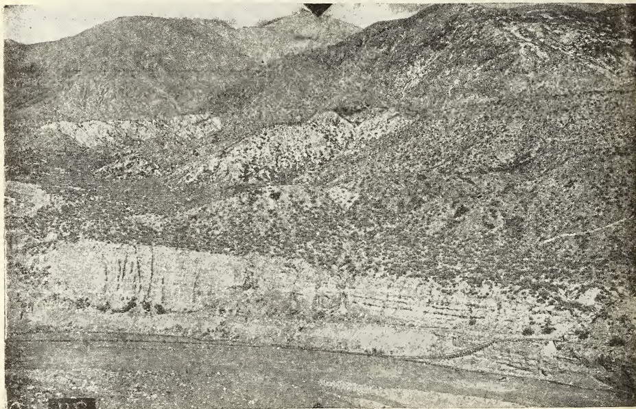
FIG. 5. — Vista parcial de una de las márgenes del río Mendoza donde puede observarse la destrucción causada por las aguas en la línea férrea.
