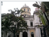
Palácio Arariboia, antiga sede da prefeitura de Niterói, inaugurado em 1910. Na década de 1960, o prédio foi tombado pela Prefeitura de Niterói e passou a abrigar a Secretaria Municipal de Fazenda e outros órgãos públicos municipais, passando por restaurações.
