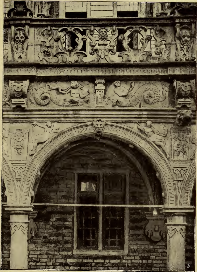
Lüder von Bentheim. Arkade mit Fries und Balustrade des Renaissancebaus von 1610—12.
