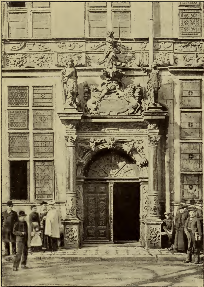
Portal des ehemaligen Kramersamthauses (jetzt Gewerbehaus) am Ansgarkirchhof 1620.
