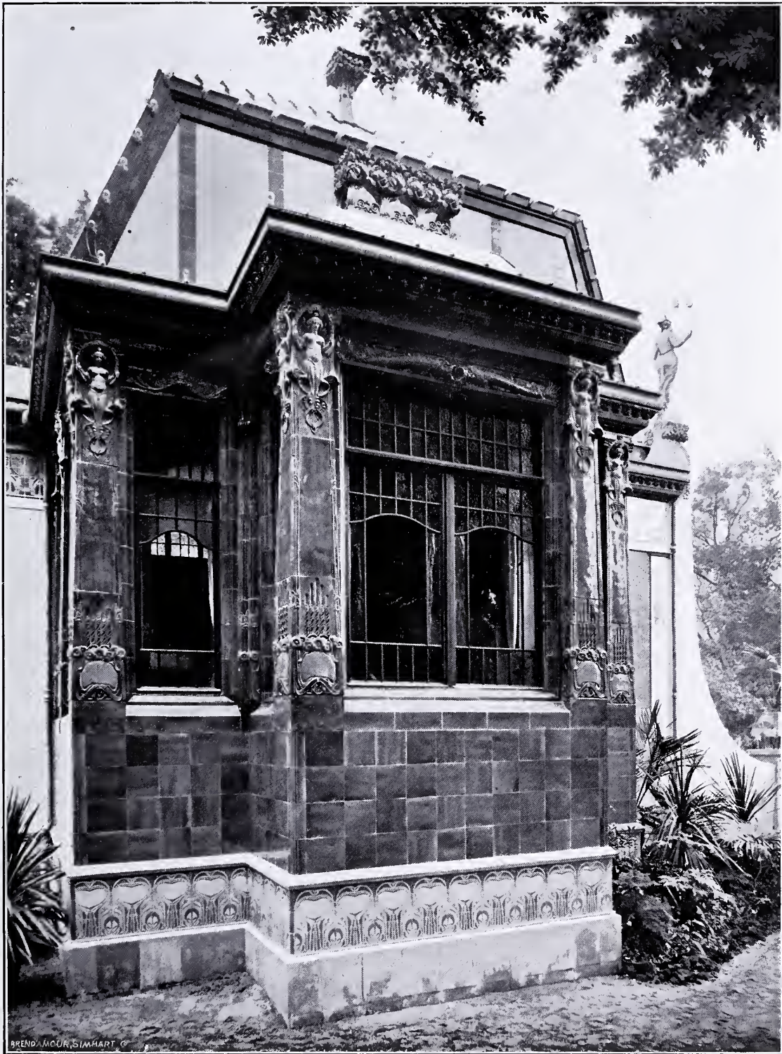
Dilleroy & Bodj Pavillon (Erker auf der Nordseite)
