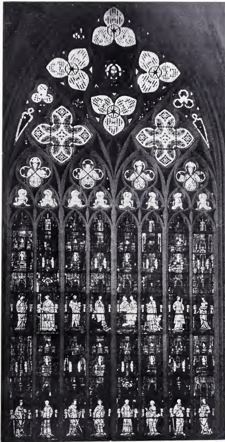
Abb. 383. Gesamtansicht des Altenberger Westfensters vor der letzten Instandsetzung.
