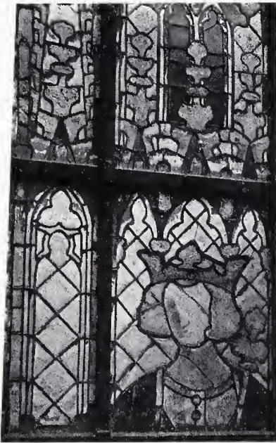
Abb. 58. Außenansicht eines Hochchorfensters am Kölner Dom, das Bleigerippe deutlich erkennbar.
