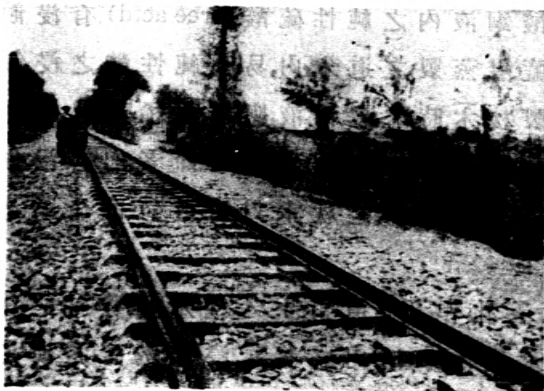
圖（一）平漢路鋪洋灰枕地段
