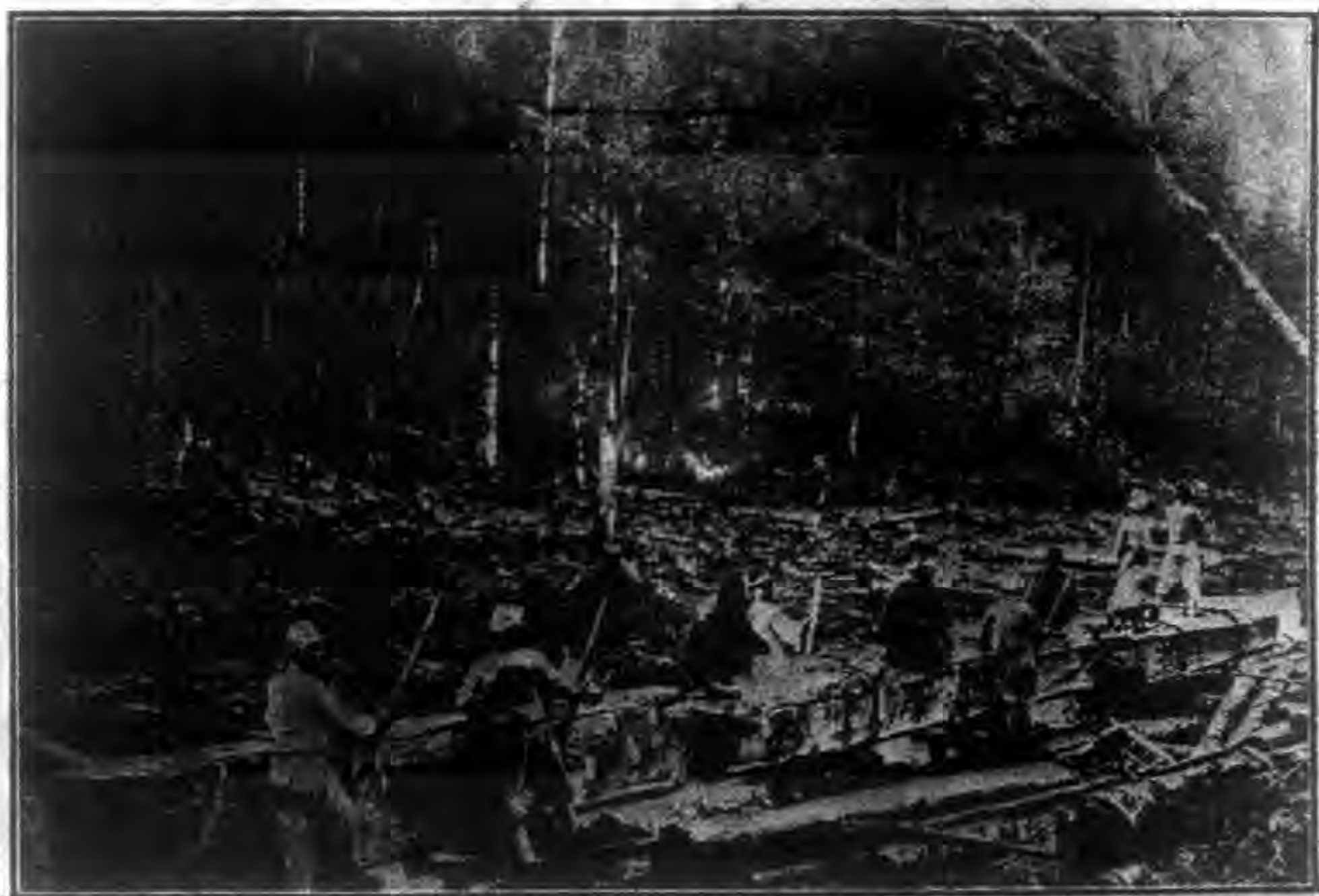
十 九 道 溝 支 流 輕 便 鐵 道 運 材 之 圖
