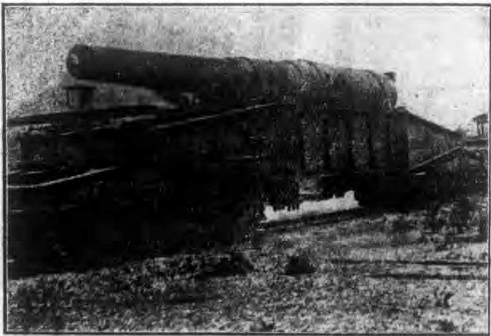
此砲之大。冠於全球。計長五十英尺。重百五十噸。預定裝置於巴拿馬運河太平洋方面之河口。以資防護。
