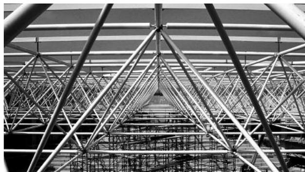
zione delle caratteristiche di sollecitazione cui sono sottoposti i vari componenti. L'angolo formato tra due facce è di  $70^{\circ}31'44''$ , mentre l'angolo formato tra uno spigolo e la faccia su cui si proietta è di  $54^{\circ}44'8''$ .
