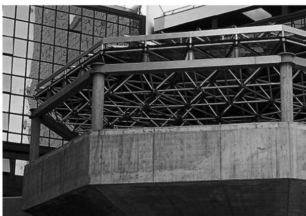
renze circoscritte ai triangoli isosceli del secondo reticolo, si ottengono i correnti superiori ed inferiori di una struttura ottagonale reticolare spaziale a doppio strato, le cui diagonali, di lunghezza pari a  $\ell_1$ , sono le congiungenti dei nodi del reticolo superiore con quelli della griglia inferiore.
