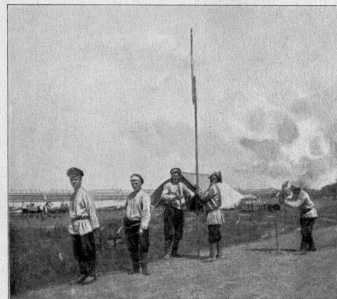
Прокладка полевого телеграфа.
