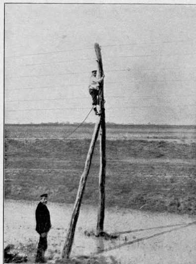
Прокладка телеграфной линии.
