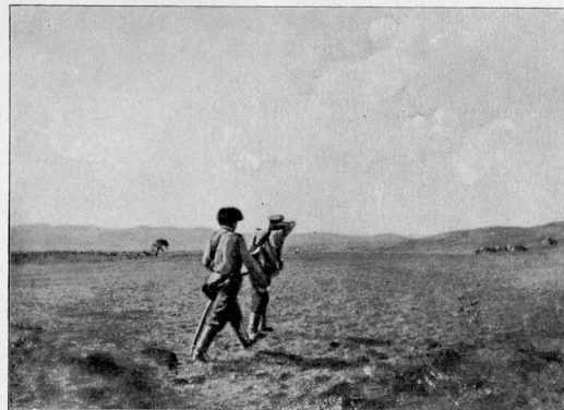
Прокладка полевого телеграфнаго кабеля.
