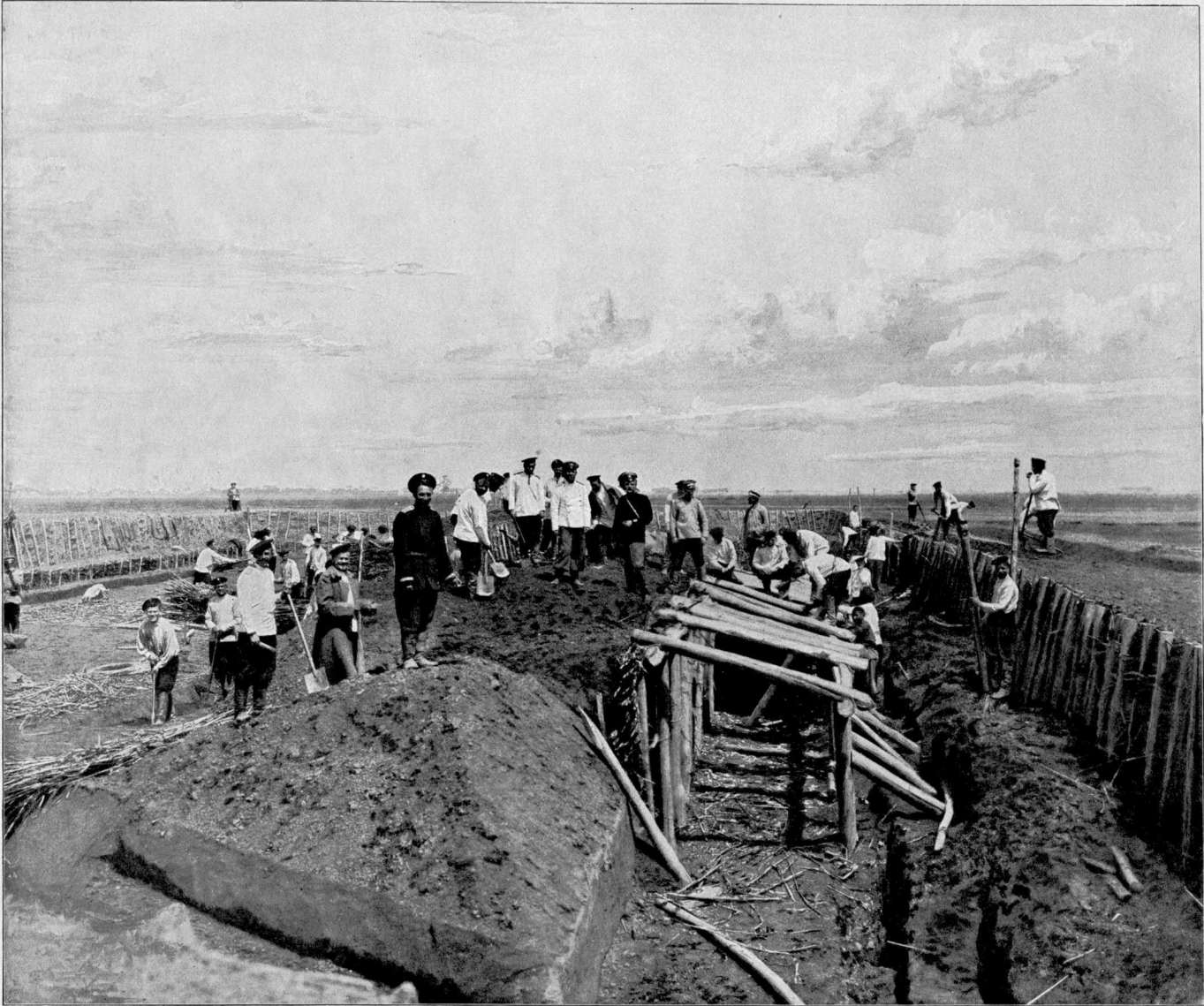
Постройка редута между 3 и 4 фортами на главной Ляоянской позиции.
