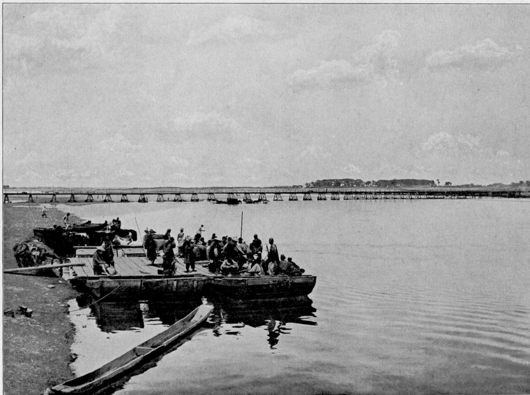
Мостъ на козлахъ черезъ рѣку Тайцзыхэ.
