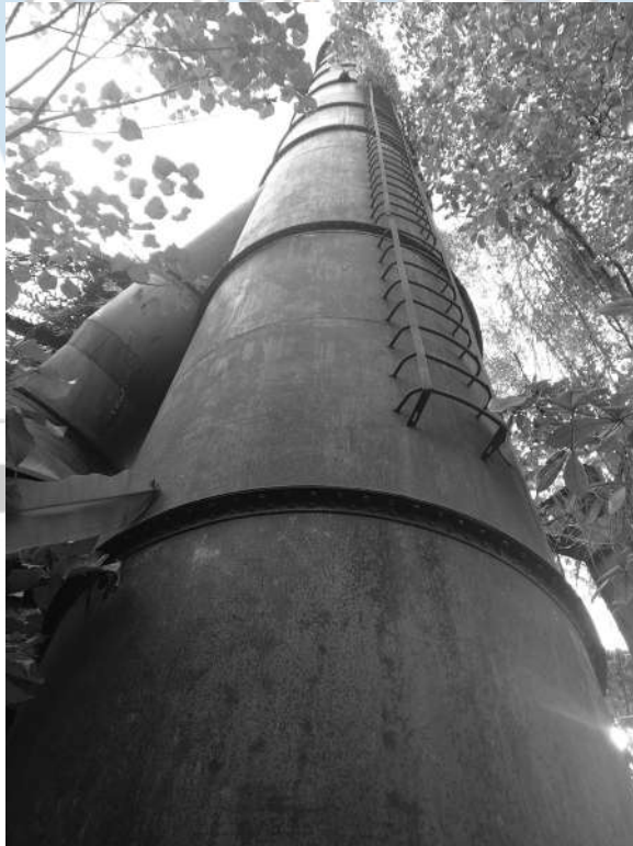
Gambar 6. Rangka cerobong asap pabrik Bruynzeel (Dokumentasi lapangan oleh tim, 2018)
