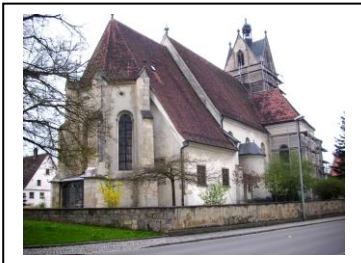
Altheim-Ansicht von Nordosten mit Kirche über Kirchhofmauer-030510
