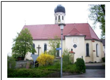
Schwendi-Ansicht von Süden mit Kirche über ehemaligen Kirchhof-020510
