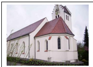
Schweinhausen-Ansicht von Südosten mit Chor und Langhaus vor Kirchturm-020510
