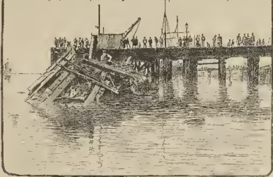
Maquina perforadora y tablas flotantes despues de la 2ª explosion.
