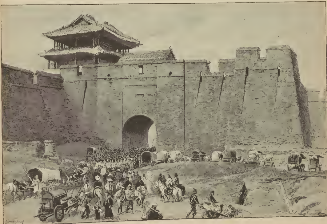
Muralla oriental de la ciudad sagrada de Mukden en China
