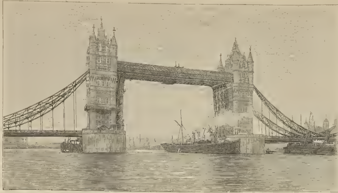
Fig. 3. - El puente de la Torre abierto (de fotografía)
