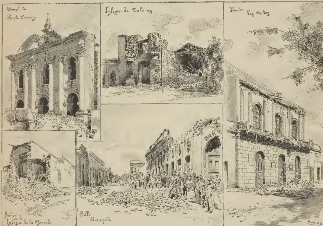
REPÚBLICA ARGENTINA. - Terremotos ocurridos en las provincias de San Juan y La Rioja el día 27 de octubre último. - Efectos del terremoto en la ciudad de San Juan.
