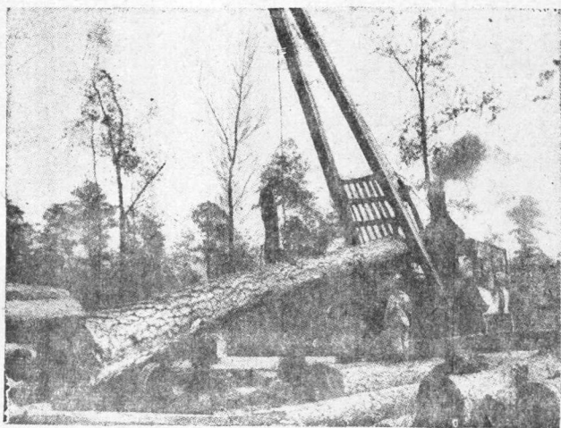
用起重機吊起巨木，裝上貨車。
