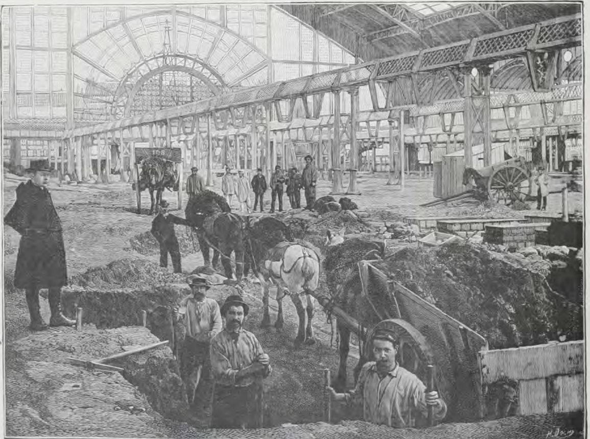
TRAVAUX D'INSTALLATION DES MACHINES.
