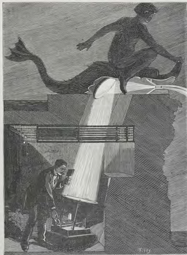
Fig. 7. — Disposition des projecteurs électriques éclairant les jets horizontaux.
