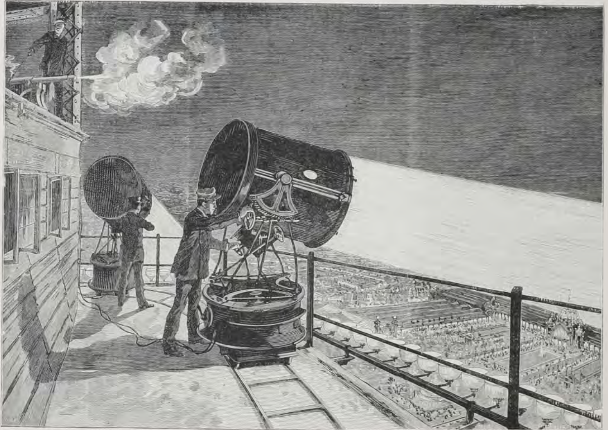
MANŒUVRE DES PROJECTEURS SUR LA TOUR EIFFEL.
