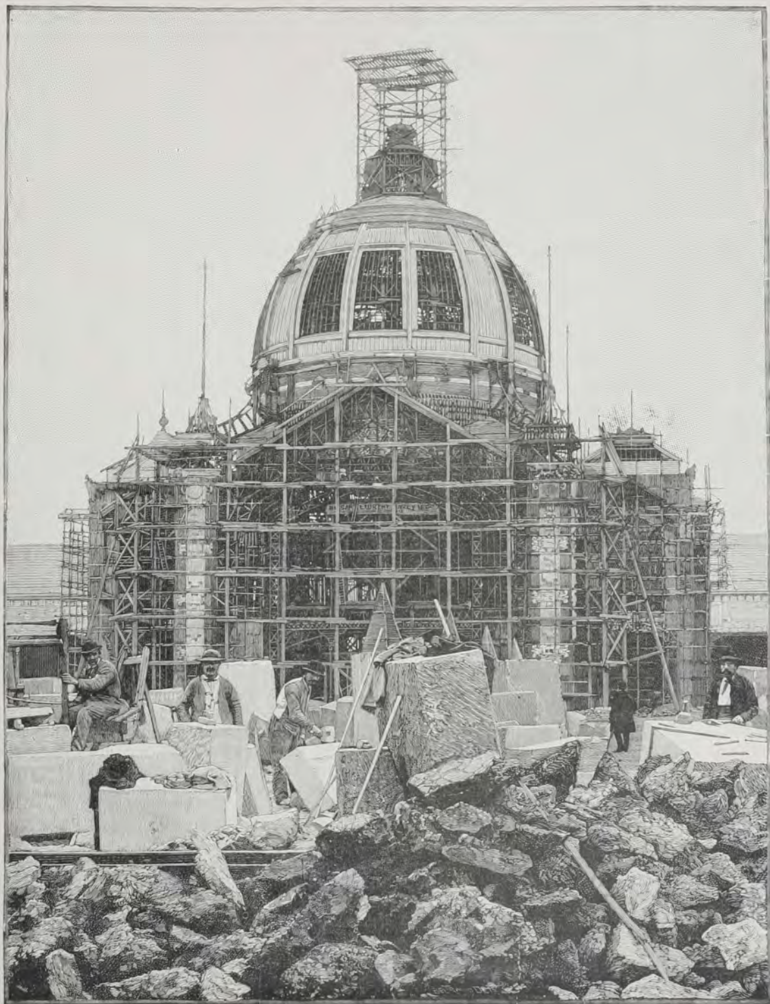
LA PORTE PRINCIPALE ET LE DÔME CENTRAL EN CONSTRUCTION (D'après la photographie de M. Giard).
