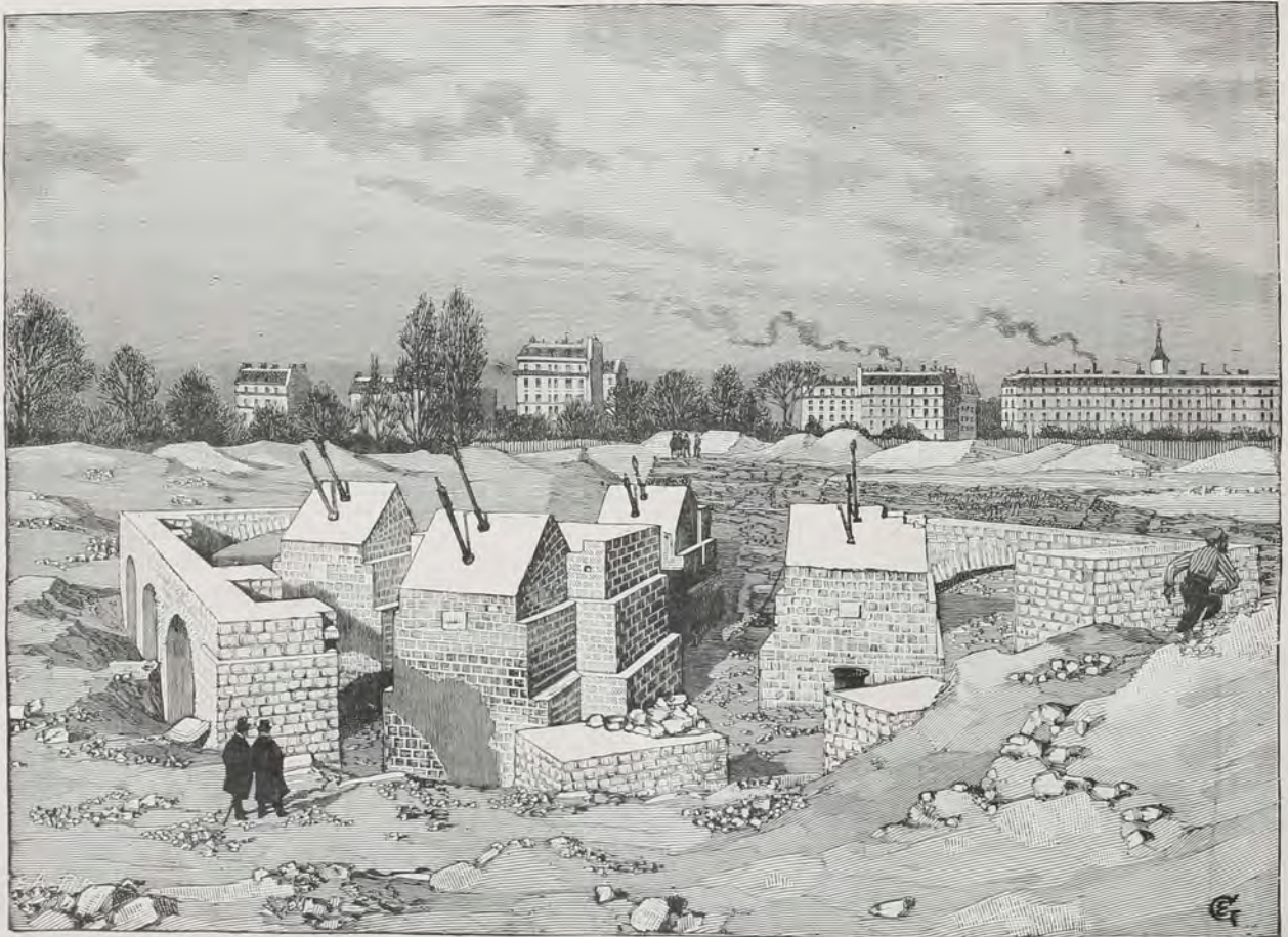
LES FONDATIONS DE LA TOUR EIFFEL. — PILE D'UN PIED DU CÔTÉ DE L'ÉCOLE MILITAIRE
