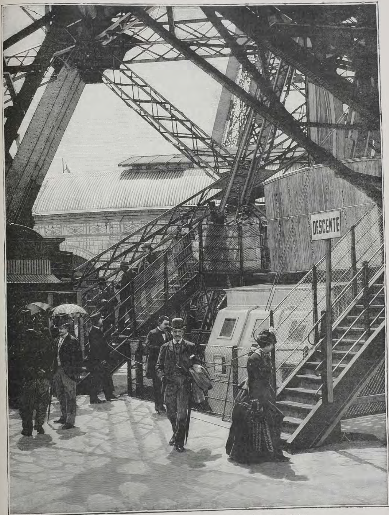
LA TOUR EIFFEL : ASCENSEUR DE LA PREMIÈRE PLATE-FORME.
