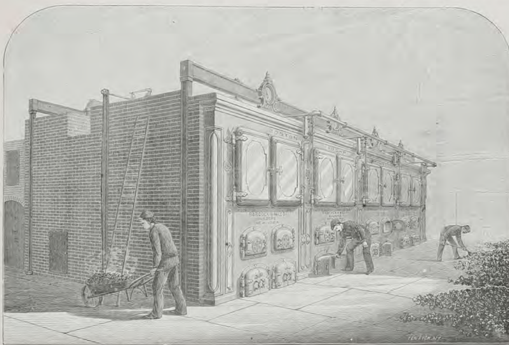
Fig. 2. — CHAUDIÈRES BABCOCK ET WILCOX.
