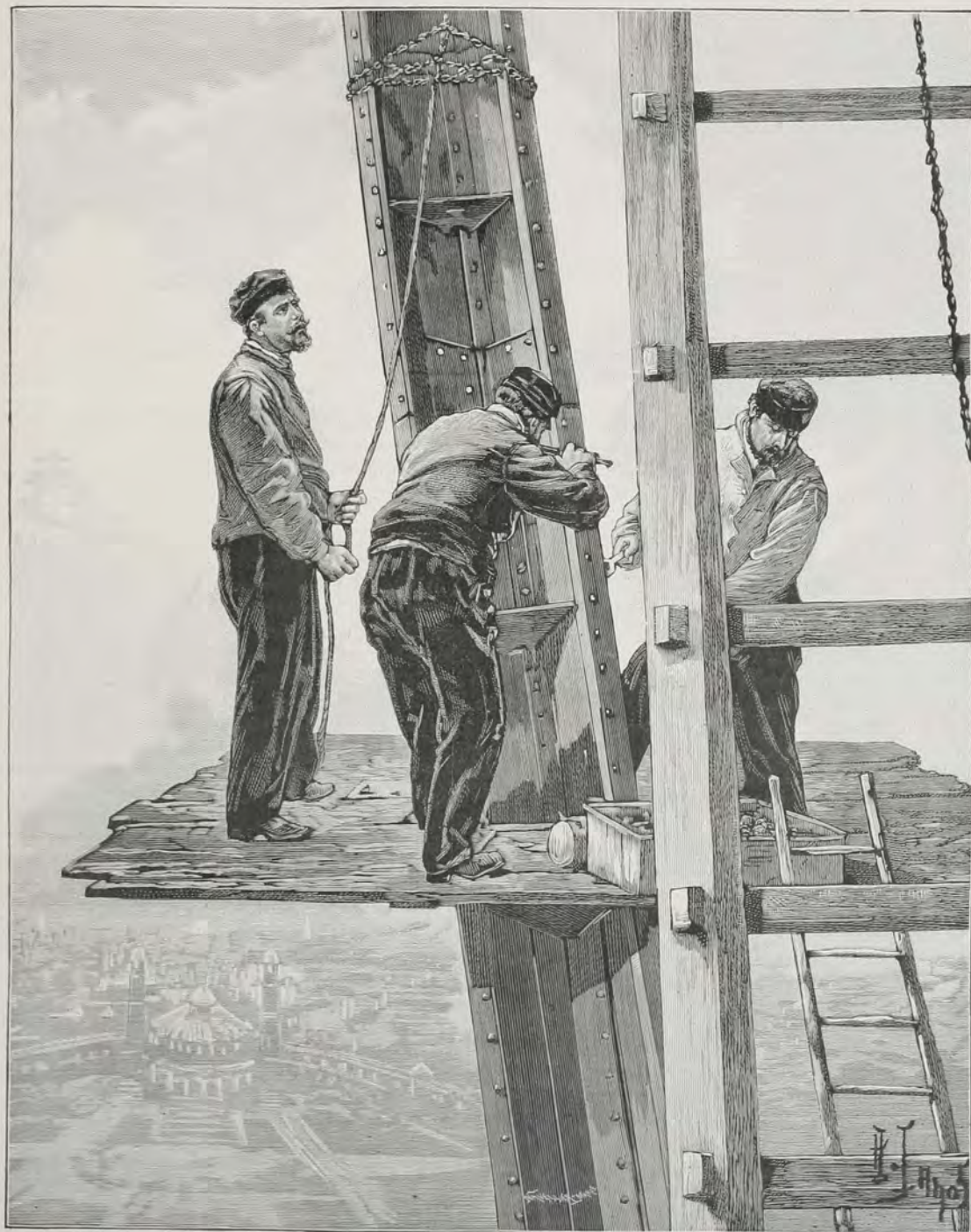
LES TRAVAUX DE LA TOUR EIFFEL. — A 180 MÈTRES EN L'AIR. — BOULONNAGE DU JOINT DES DEUX ARBALETRIERS
