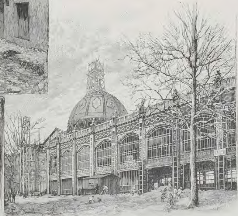
LES TRAVAUX DU CHAMP DE MARS. — 1. Le Venezuela. — 2. L'Égypte: Une rue au Caire. — 3. Le Palais des Arts libéraux.
