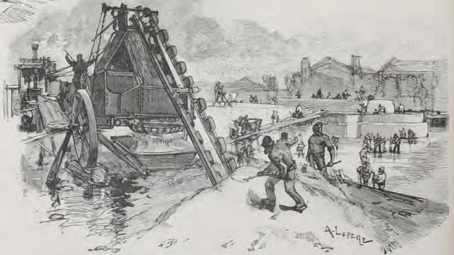
LES TRAVAUX DE LA FONTAINE MONUMENTALE AU SABBIN DU CHAMP DE MARS.
