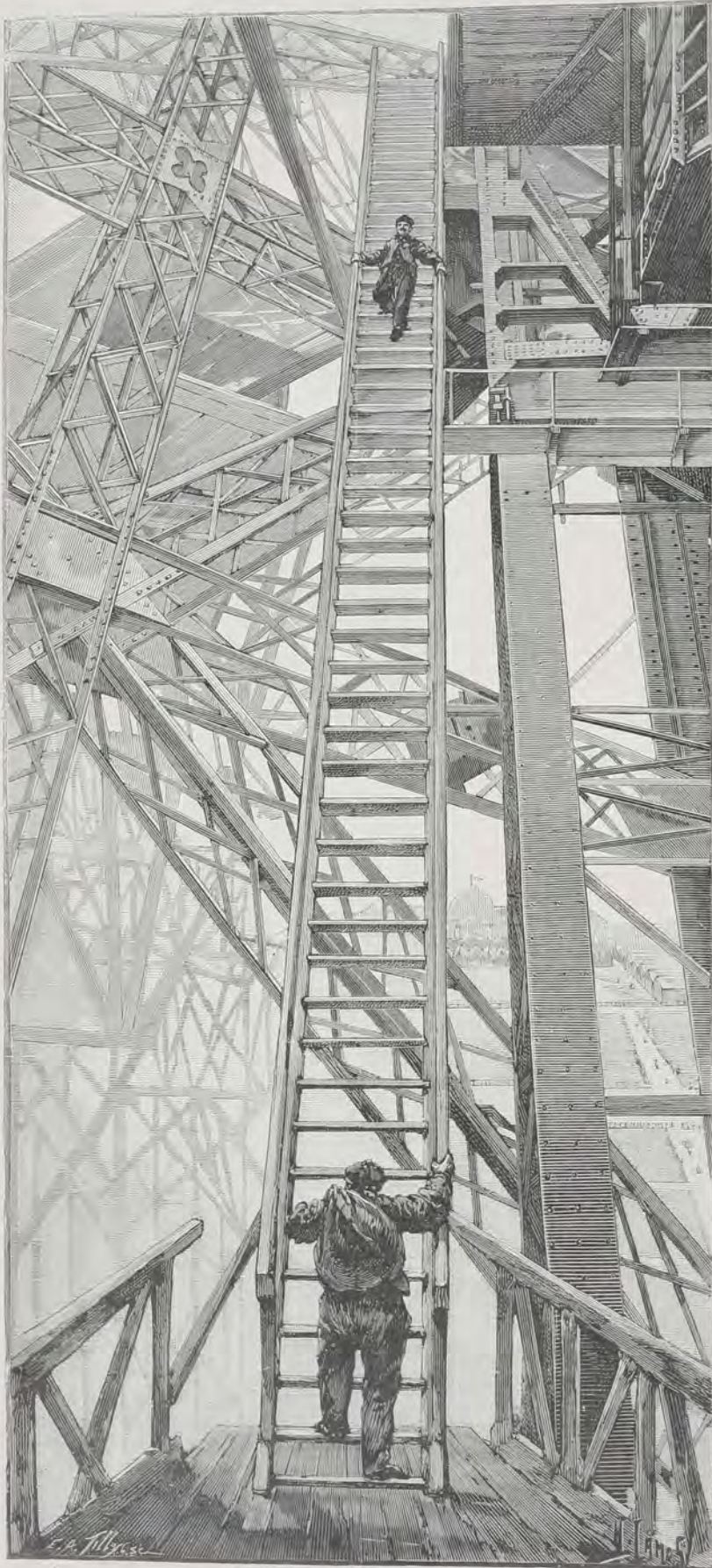
LES TRAVAUX DE LA TOUR EIFFEL. — La Grande Echelle.
