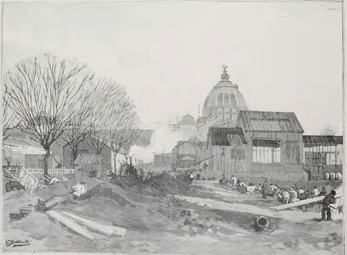
LES TRAVAUX DU CHAMP DE MARS. — Les terrassements sur l'emplacement de la fontaine monumentale.
