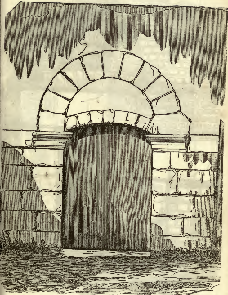
PORTE DANS LES MURS ANTIQUES DE DAX.
