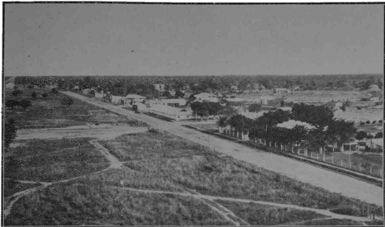
Vista general del Pueblo de "Las Lomitas" nacido y desarrollado en base al Fortín allí instalado
