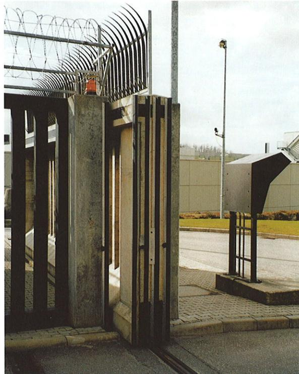
Spezielle Schaltleisten wurden für die Torabsicherung entwickelt.
