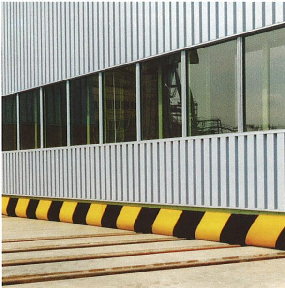
Der Mayser Safety Bumper ist ein Prallkissen aus verhäutetem Polyurethanschaum mit eingebautem Signalgeber. Er wird seit 1997 in Lindenberg gefertigt.
