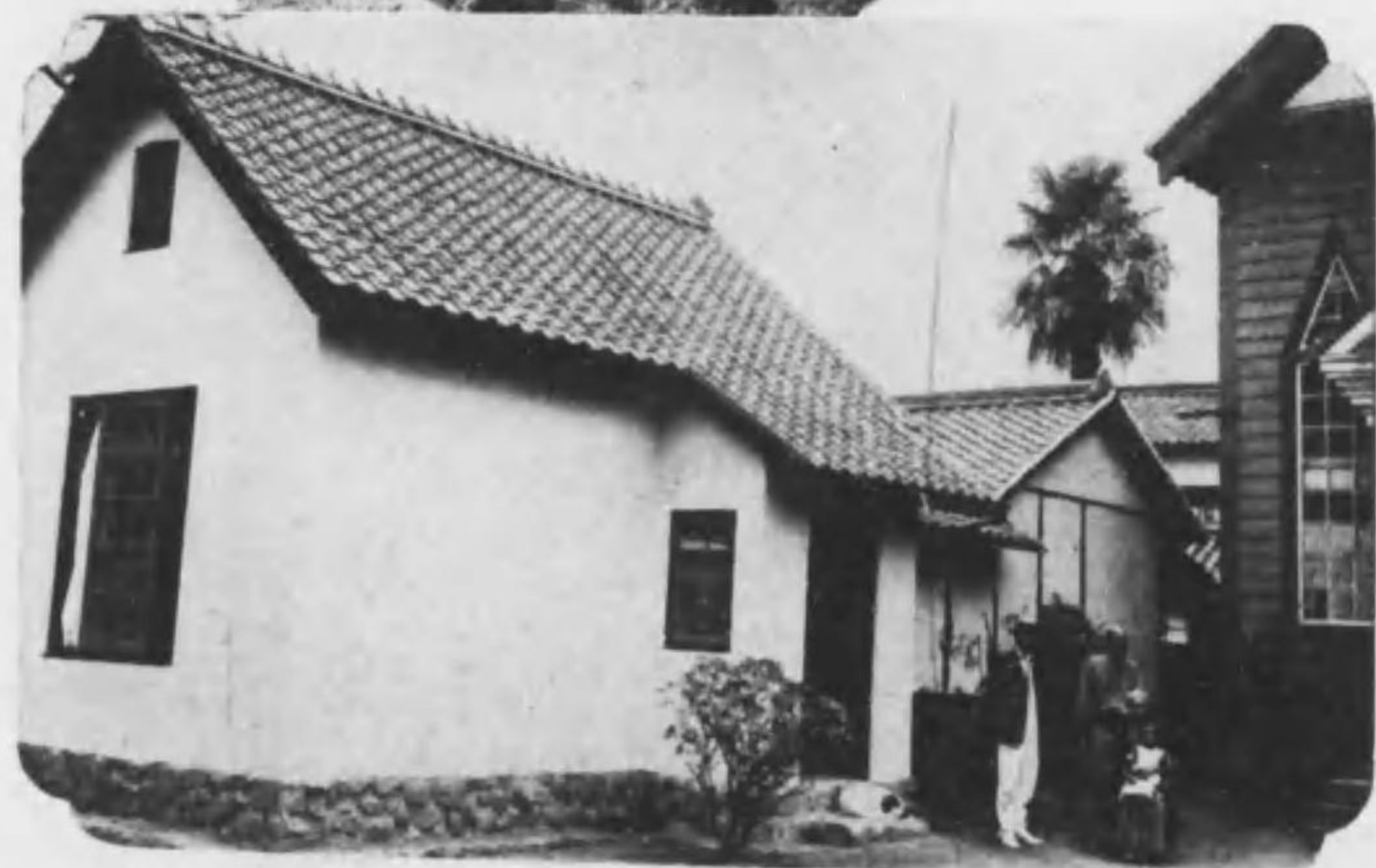
上 鳴子教會 (階上増築) (増築起工昭七、七、二〇、竣工 全年九、一〇) 下 天城教會附屬館 (起工大、四、一〇、竣工全 年七月八日)
