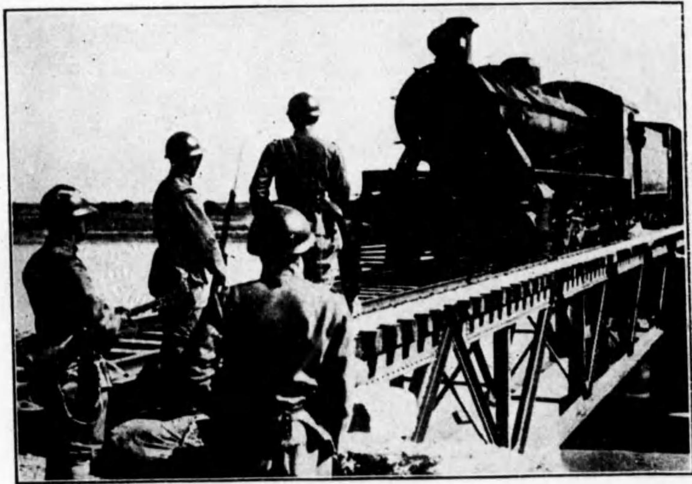
北寧大凌河鐵橋を警備する日本軍
