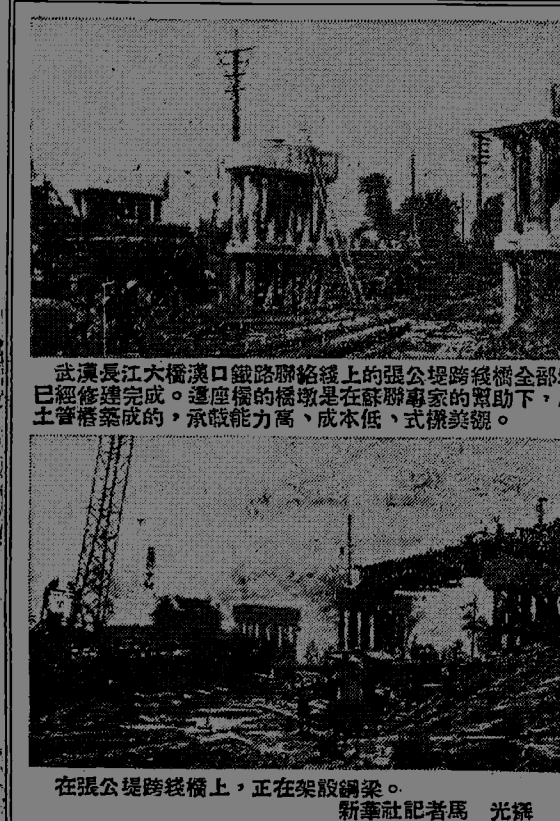
武漢長江大橋的組成部分正在進行架梁工作
