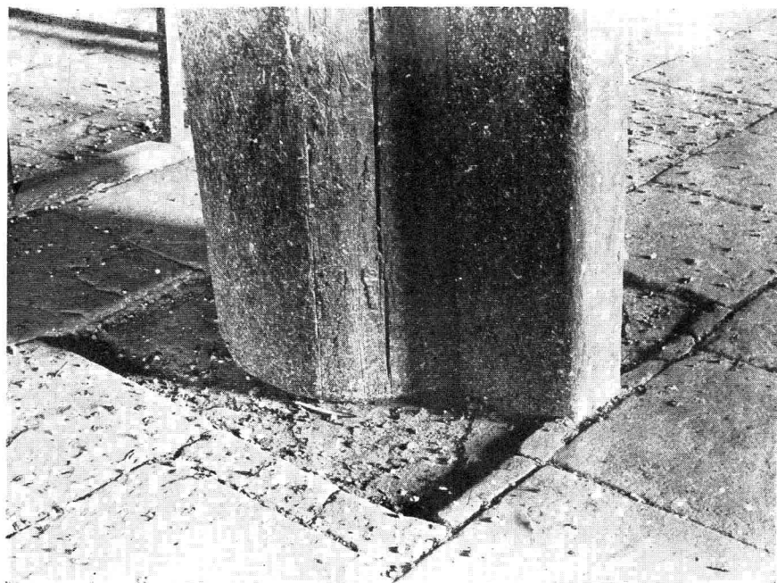
甲 大同善化寺大雄寶殿平柱礎
