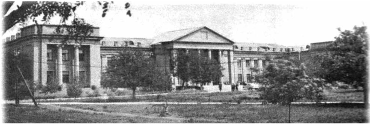
Новозбудована будівля «Красноармійськшахтобуд». Нині – центральний корпус КІІ
