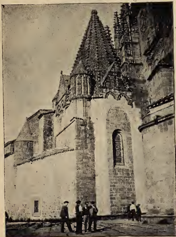
Catedral de Plasencia. Sala Capitular.--Vista exterior.
