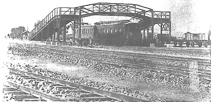
鄆城車站——西傍縣城北據洛河東通周口交通便利將來周鄆支線完成此站地位當更重要也
