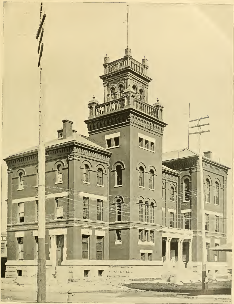
U. S. CUSTOM-HOUSE, EL PASO.
