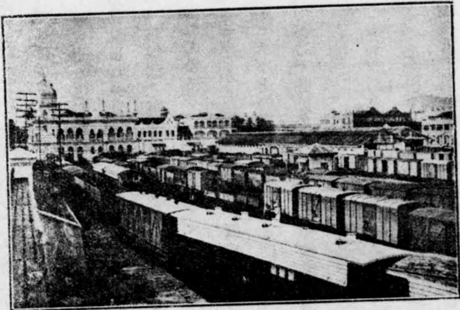
クアラ・ラムバー駅構内
