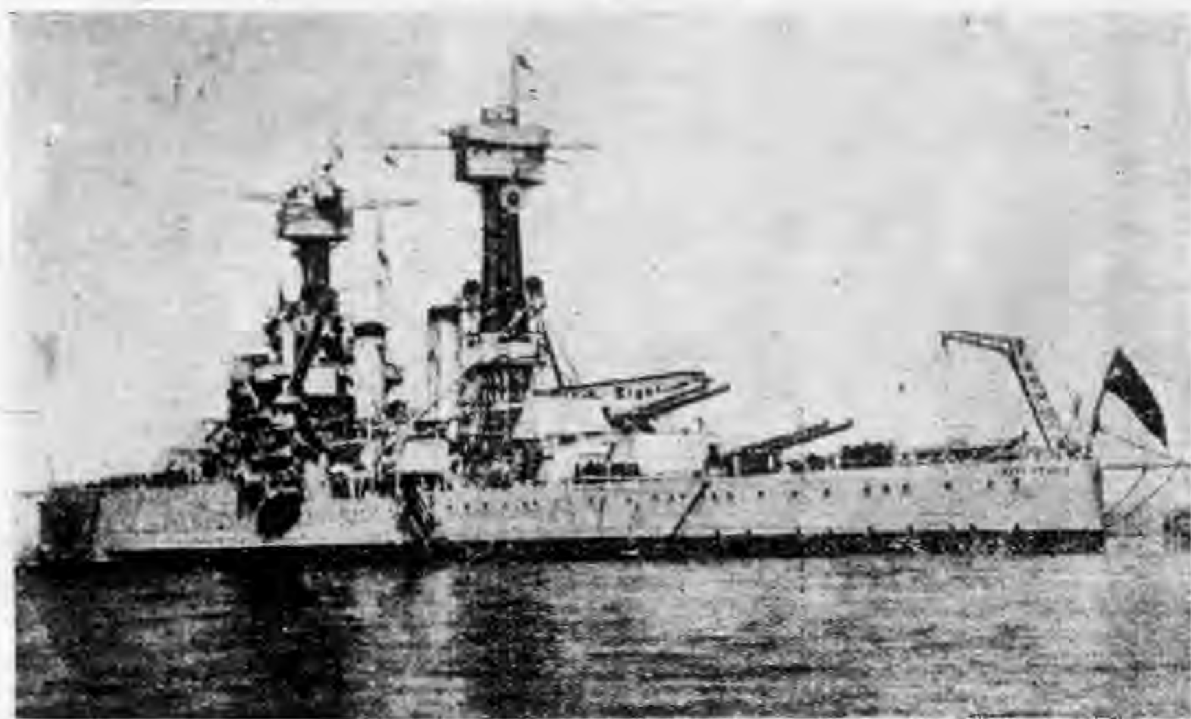
美國裝甲艦 West Virginia 三萬一千八百噸，於一九二一年進水，此後無復新造者，砲之口徑，有 406 密釐者八尊，127 密釐者十二尊，高射砲四尊，口徑 57 密釐，魚雷管兩門，口徑 533 密釐，飛機之射出機兩架，
