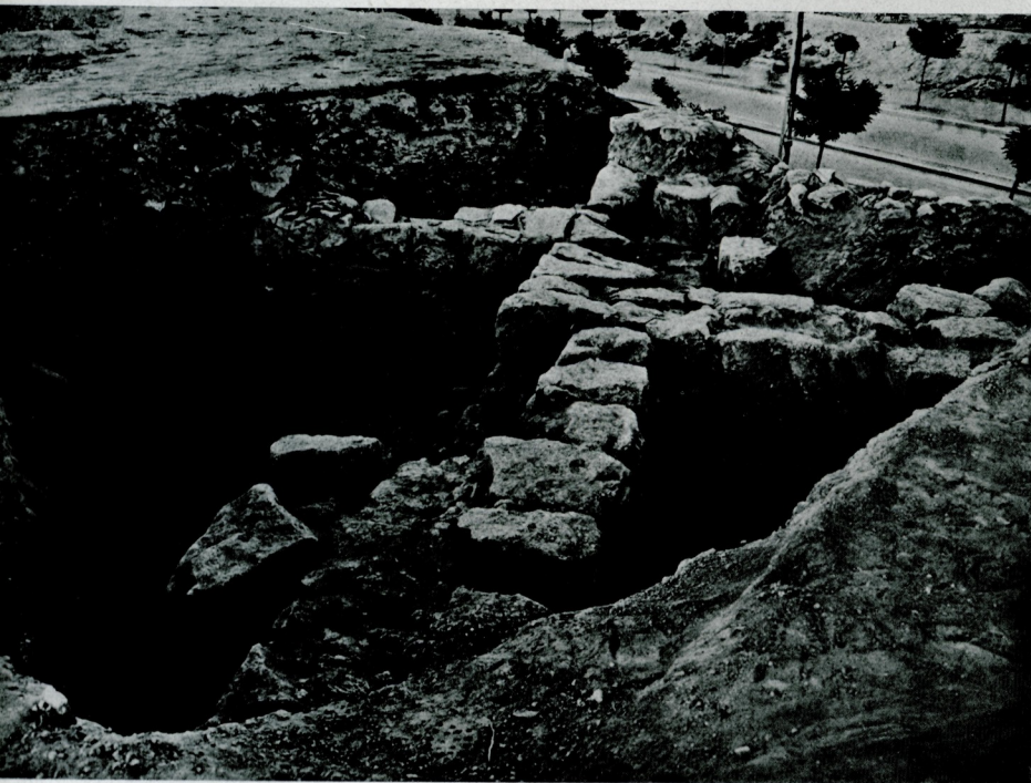
Çankırıkapı (côté Nord-Est) : Début des travaux. Tranchée VII. Fondations d'une vieille maison turque
