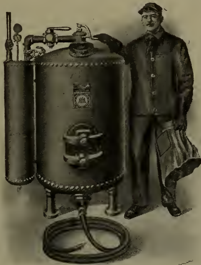
Fig. 129—Hose Sand Blast Machine.
