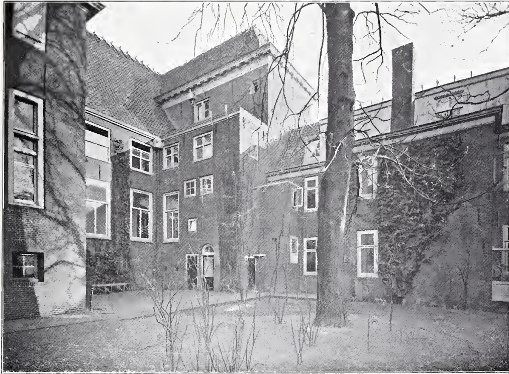
FIG. 4. KEUKENUIT- BOUW, BINNEN- PL. DER MEISJES- AFD. EN RECH- TERVLEUGEL DER O.VR. AFD. (WETERINGDW.STR.)
