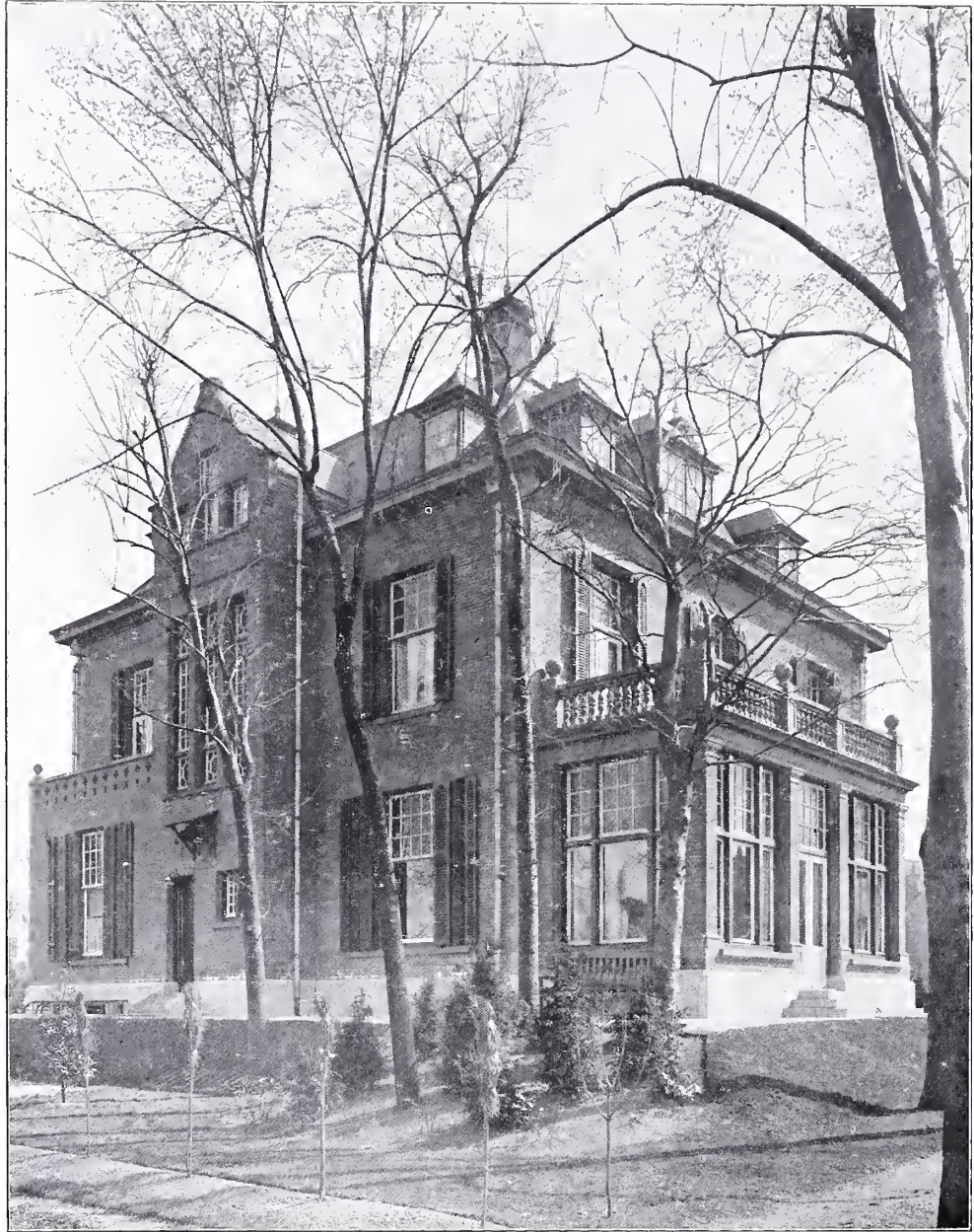
PLAAT XXVII. HEERENHUIS AAN DEN WALENBURGERWEG TE ROTTERDAM (ACHTER- EN ZIJGEVEL).
