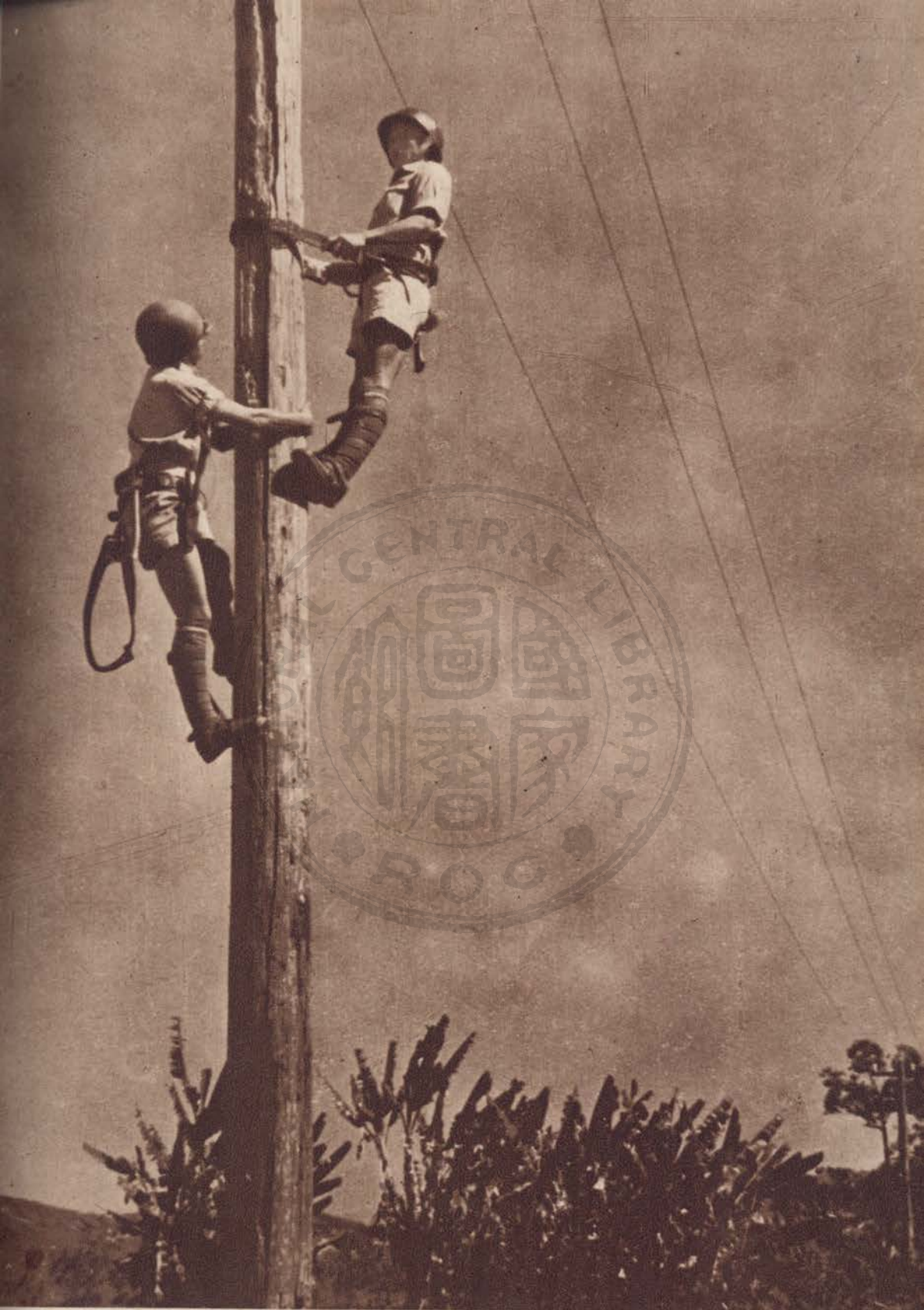
通信兵架設電綫，由後方向前方延伸。
