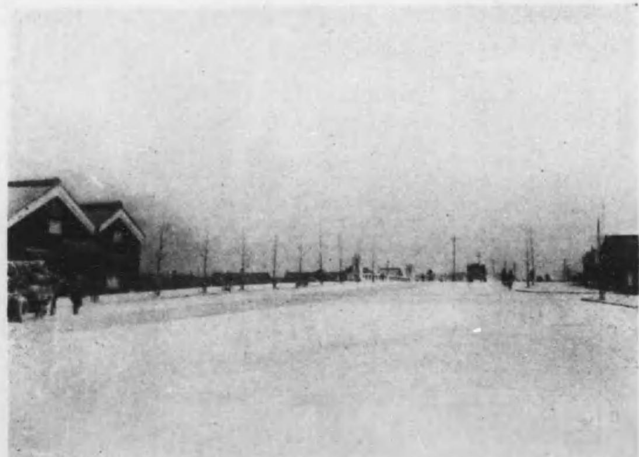
(△望テ橋河運リヨ点起線色一) 線 町 主 水 第テシト線幹ルナ要重上利用ノ河運川中シ有テ七米二十三員巾ハ線路本 モルセ設新シ費テ圓萬餘十四費工テ於ニ度年十和昭リヨニ業事施急回二 リナノ
