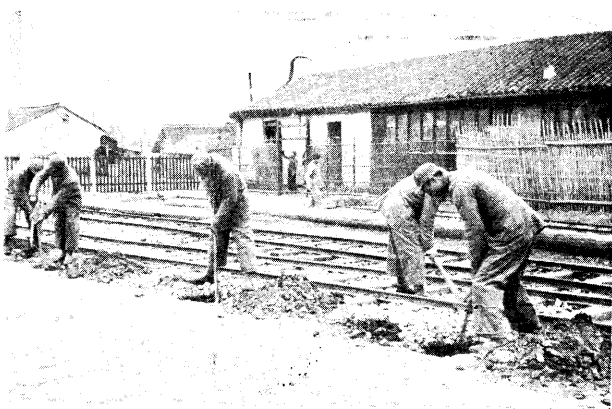
上川鐵路路軌修理
