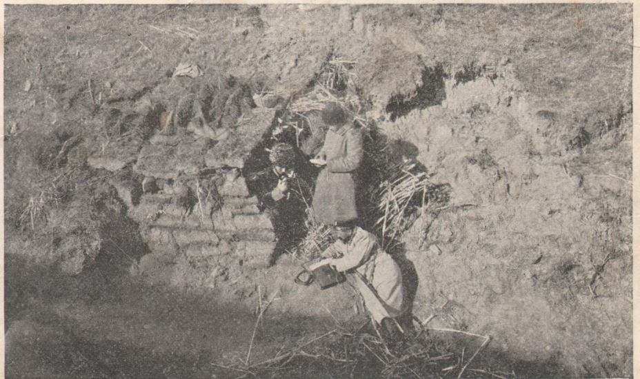
Телефонная станція на передовой позиціи Эрлдагоу. По фот. нашего корреспондента В. Булла авт. «Нивы».
