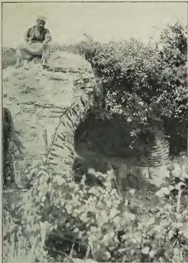
Abb. 3. Ak Köprü, Brückenreste auf dem linken Ufer der mittleren Biga Tschai (Granikus).
