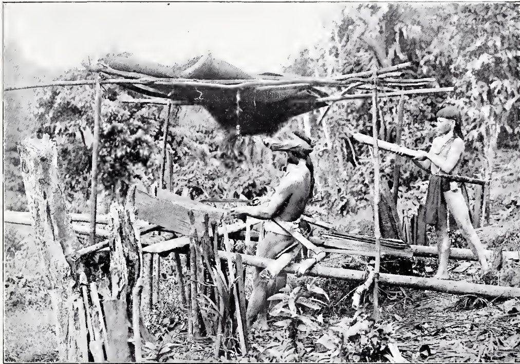
FIG. 17. HET VER- VAARDIGEN DER IJZERHOUTEN DAKBEDEKKING
