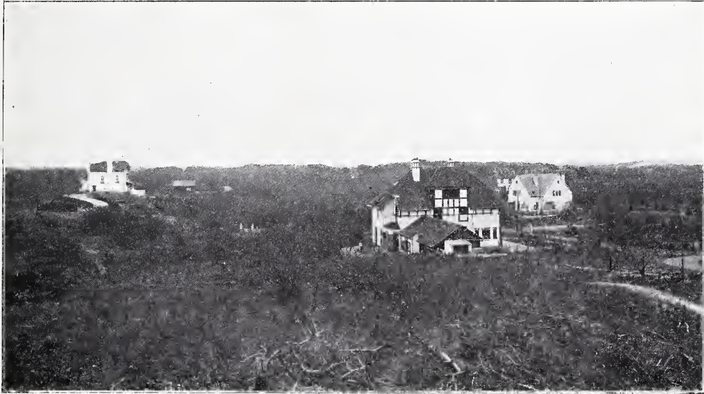
FIG. 1. VILLA „DE HOEVE” TE AERDENHOUT.
