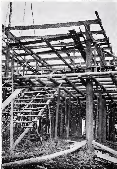
FIG. 13. EEN DEEL VAN HET IN AANBOUW ZIJNDE HUIS.
