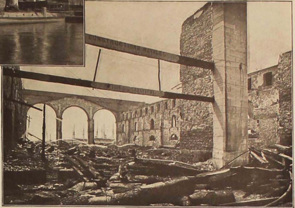
Intérieur du bâtiment central.
