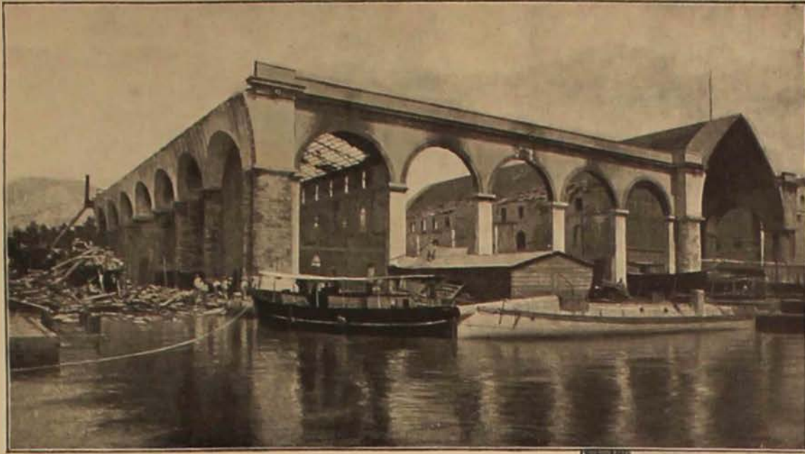
Ensemble des bâtiments détruits : côté sud.
