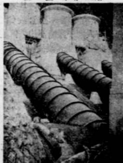
銲接，銲接部利用電熱燒銀之，以使接合點之強度增大，鐵管共四條，鋼板厚為 1.4m，為防備膨脹收縮起見，水槽出口及上部停止處，設有伸縮管，各鐵管之長為 76m，減壓水槽及水壓鐵管之外觀，示之如第 1 圖。
